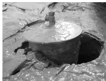
图11 水平破坏模式的锚 Fig.11 Anchor in horizontal failure mode
